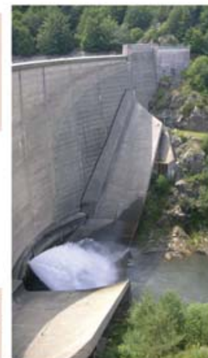
Barrage de La Palisse : la Loire réduite à un filet d'eau Crédit : SOS Loire Vivante - ERN France
