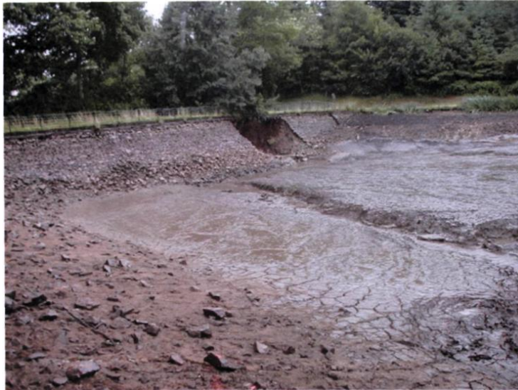
Barrage des Ouches (H = 7 m, 49 000 m 3 ), victime d'une rupture par érosion interne, deux siècles après sa construction
