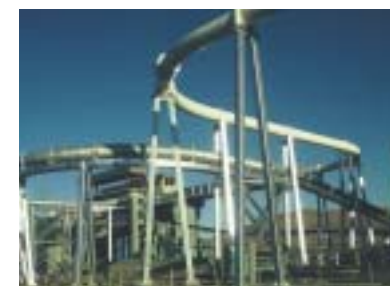
Dispositif invraisemblable de dévalaison des jeunes saumons sur le barrage Mac Narry (Columbia-USA)
