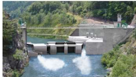
Nouvel ouvrage : 4 m de haut Retenue de 350 m
