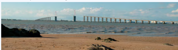
Le Pont de Saint Nazaire © SOSLV
