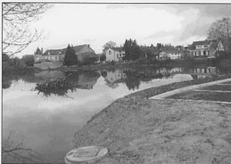
Decize - Parking Leclerc - sur remblai - en zone aléa fort - illégal
