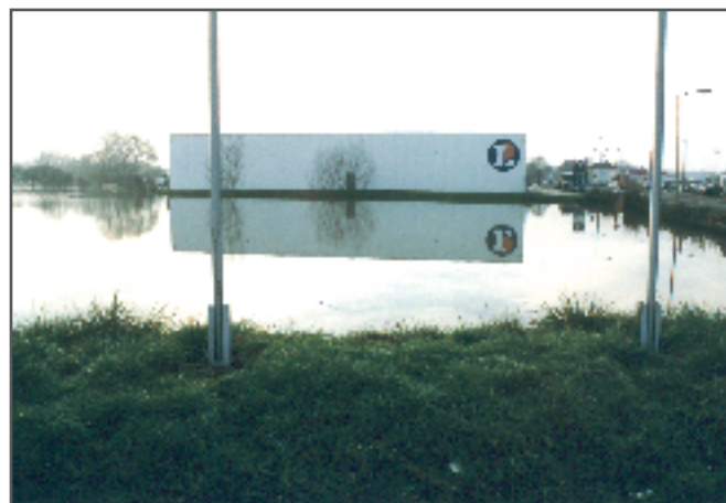
Decize : inondation de la zone commerciale en 2003 Partie remblayée à tort par la suite
