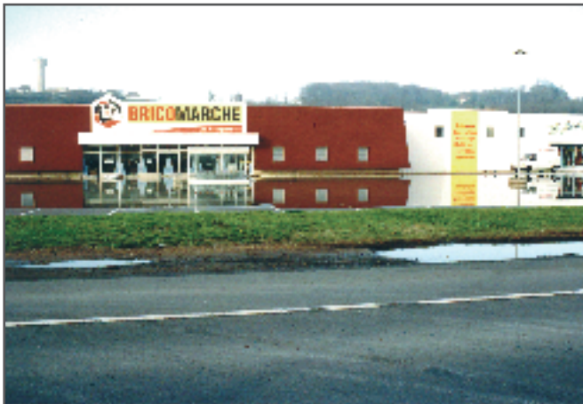
Decize : inondation de la zone commerciale en 2003
