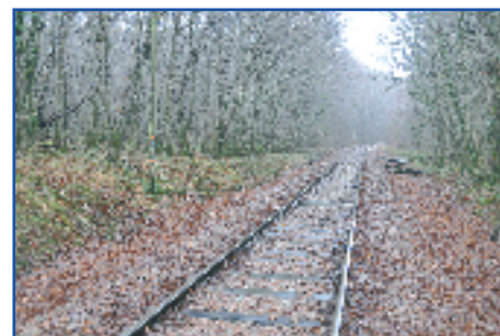
Une voie unique non électrifiée
