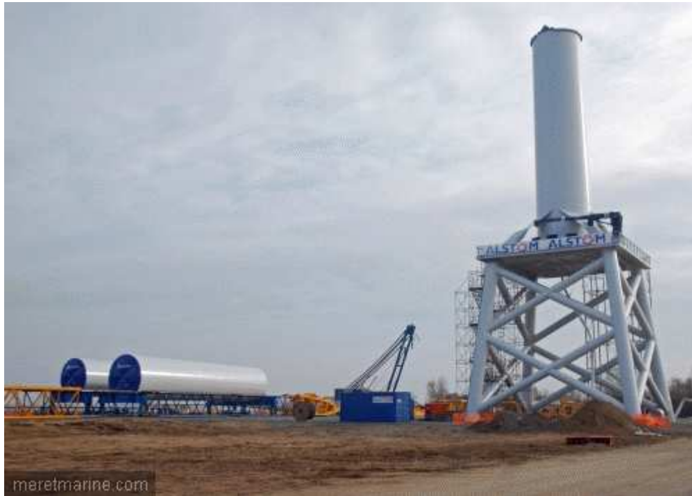
Assemblage de l'éolienne d'Alstom au Carnet (© : GPMNSN - ANDRE BOCQUEL)
