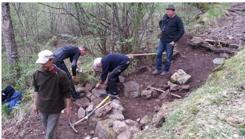
Remise en état d'une partie du sentier caladé. Copyright SOS Loire Vivante
