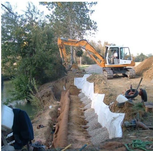
Caisson végétalisé en travaux ©Théo Duperray
