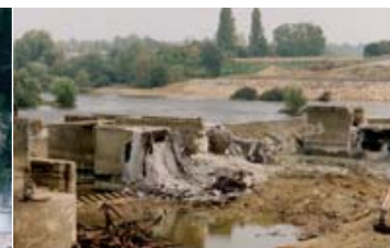
Entèvement du barrage de Maisons Rouges (Vienne) 1998
