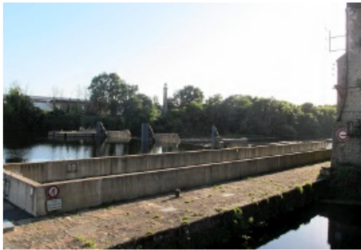
L'ancienne centrale hydroélectrique du barrage de Descartes, désaffectée depuis 1961. Le débat a réuni près d'une soixantaine de personnes.
