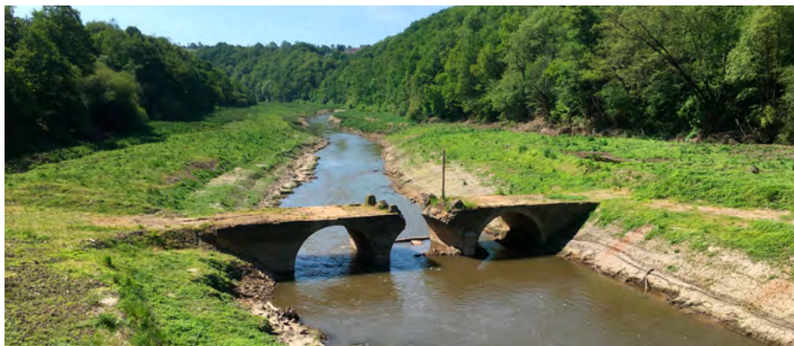
La Sélune dans son lit naturel dévoilant un ancien pont, en bout de la retenue de Vezins - ERN France
