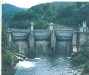
Barrage de Poutès-Monistrol
