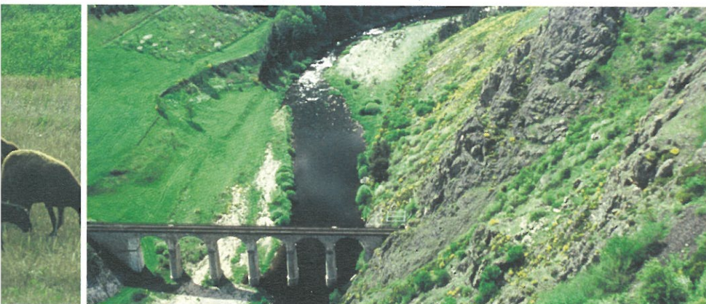
Viaduc sur le Haut Allier sur la ligne du "Cevennol"
