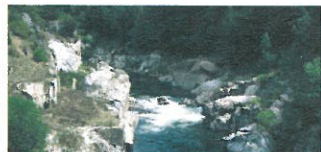
Barrage enlevé (St Etienne du Vigan), sur le Haut-Allier
