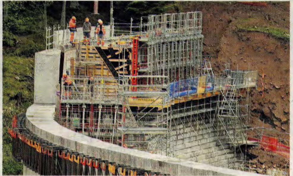
■ Les travaux de réhabilitation dans l'Ondaine du barrage des Plats, sur la Semène ont repris. Photo Claude Essertel
