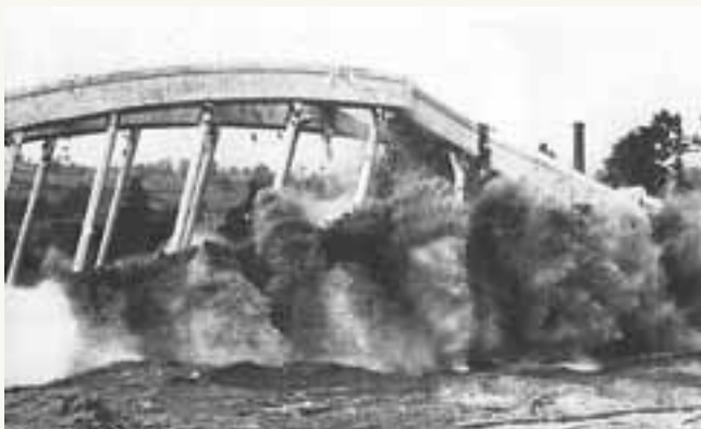
Effondrement du pont de Coubron, amont de Brives-Charensac, crue de la Loire 1980
