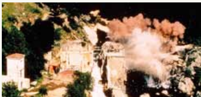
Démolition du barrage de St-Étienne-du-Vigan sur le Haut-Allier, 1998.
