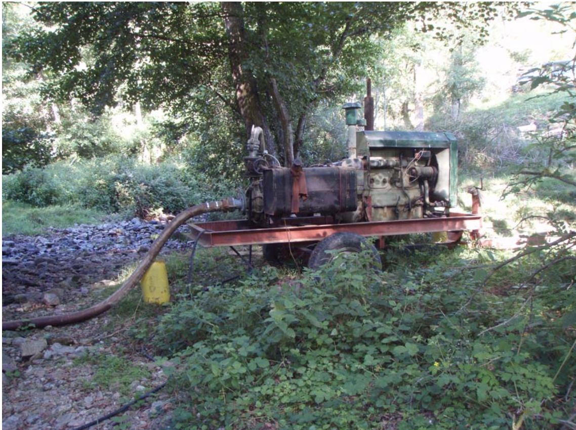
Ruisseau la Peyrusse, commune d'AUBAZAT Photo 1 et 2 : station de pompage
