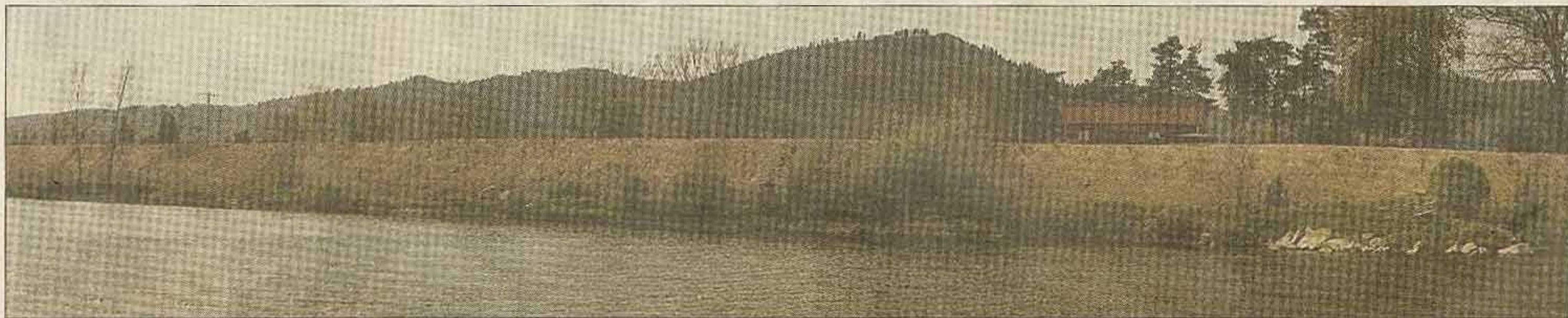
La nouvelle digue s'étend sur 1,2 km : depuis la fin de la zone d'activité (derrière le gymnase) jusqu'en dessous du camping municipal de la Garenne.
