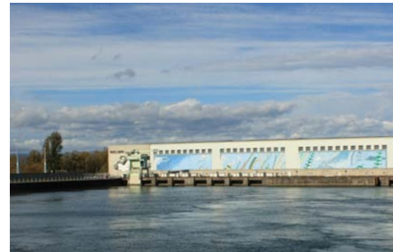
Kraftwerk Vogelgrün © ERN France
